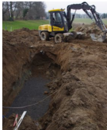
Terrassement avec sable en fond de fouille
