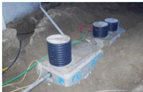
Vue de l'installation avant recouvrement
