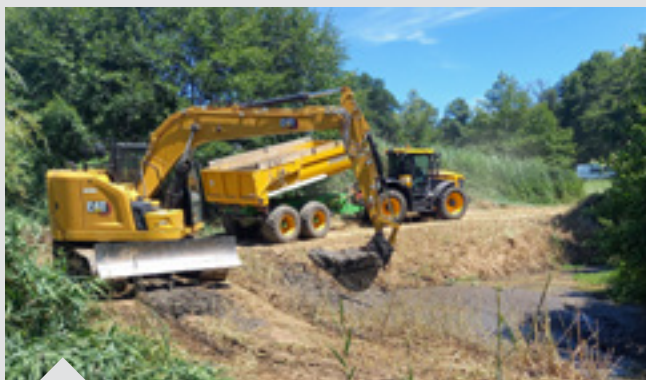
Curage et désensablage de la pointe sud du barrage
